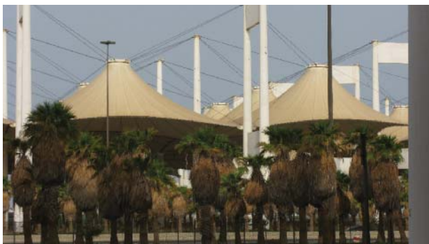
تصویر ۱. ترمینال حج فرودگاه جده ، مأخذ: دباغ ، ۱۳۸۸
